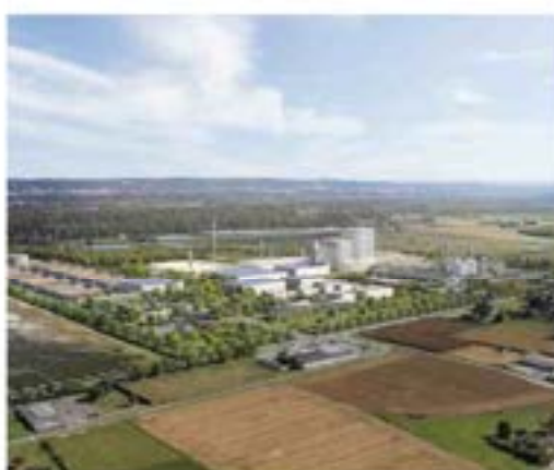
L'entreprise Elyse Energy veut produire du e-méthanol et des carburants aéronautiques durables. N. D.
