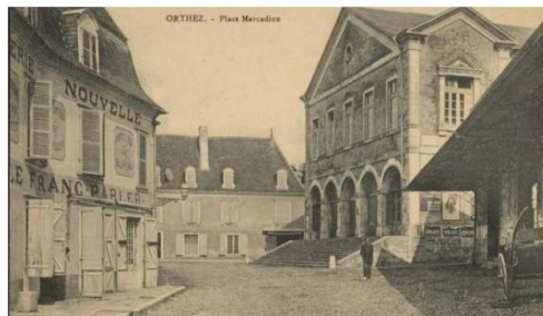
Vue de la place Marcadiou : halles neuves et halles vieilles sont côte à côte.
